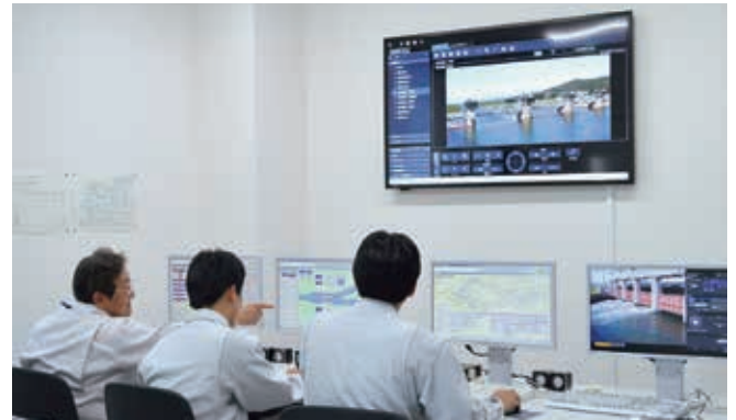
▲ 用水集中管理のようす（赤川用水管理センター）
