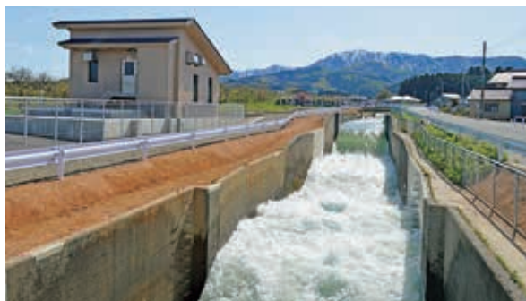
▲ 国営赤川二期事業 (H22~R3) で建造された赤川地区小水力発電所
