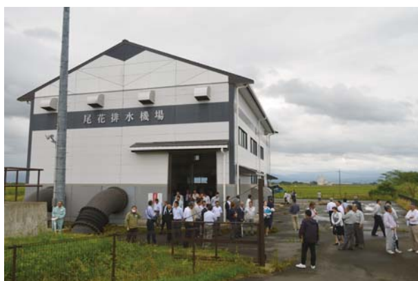
尾花排水機場
