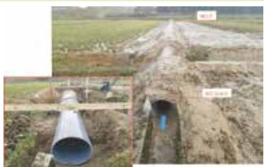
丸山用水路管路化工事
