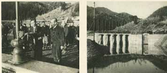
▲昭和28年 竣工通水式と菅野代頭首工
