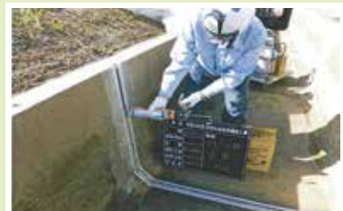
栄用水路目地補修工事
