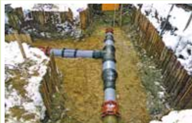
東郷堰地区パイプライン整備補修工事
