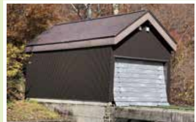
大鳥池巻上機格納庫整備補修工事
