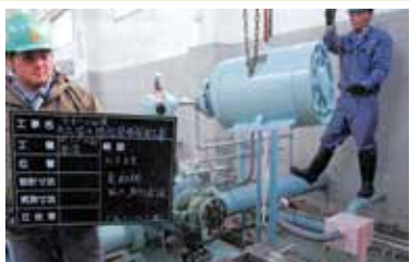
米出揚水機場整備補修工事
