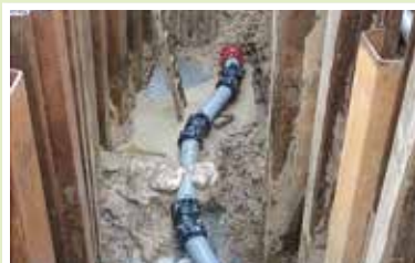
山谷揚水機場送水管漏水補修工事
